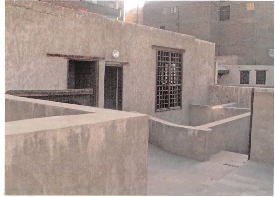
(لوحة 84) الفسحة بالدور الثاني بقسم الحریم، وتفتح عليها غرفتان، ويوجد بها الملقف الهوائي الذي يستقبل الهواء للفسحة أسفلها بالدور الأول.
